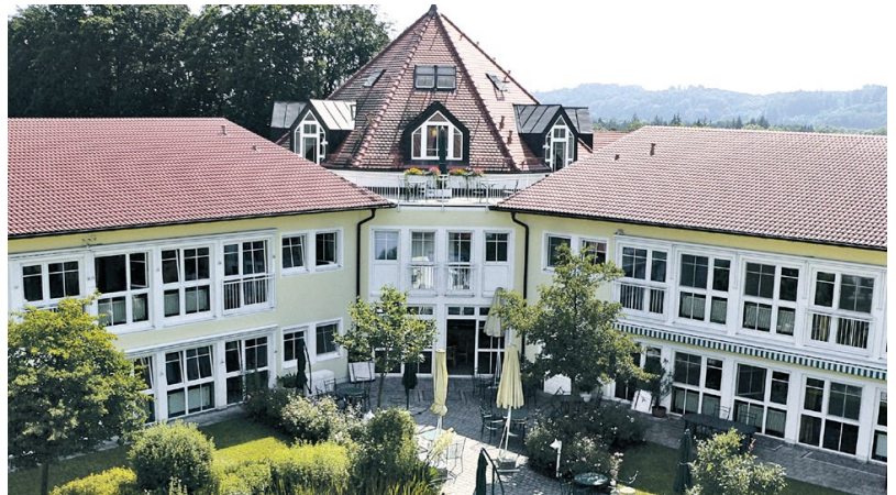
Bei der bayerischen Pur Vital Altenhilfe GmbH - hier das Pflegezentrum in Garching – war die Elektrizität mit rund 60 Prozent Spitzenreiter bei den Kosten. Hier belegen die Küchen, die Beleuchtung, die Spülmaschinen und Wäschereien in allen Heimen vordere Plätze.
